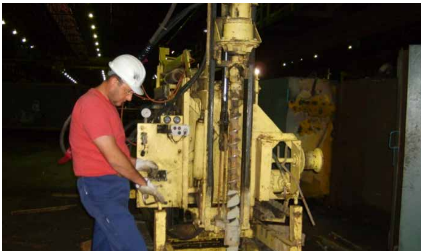
▲ INISMa : Reconnaissance géotechnique à l'intérieur d'une usine
